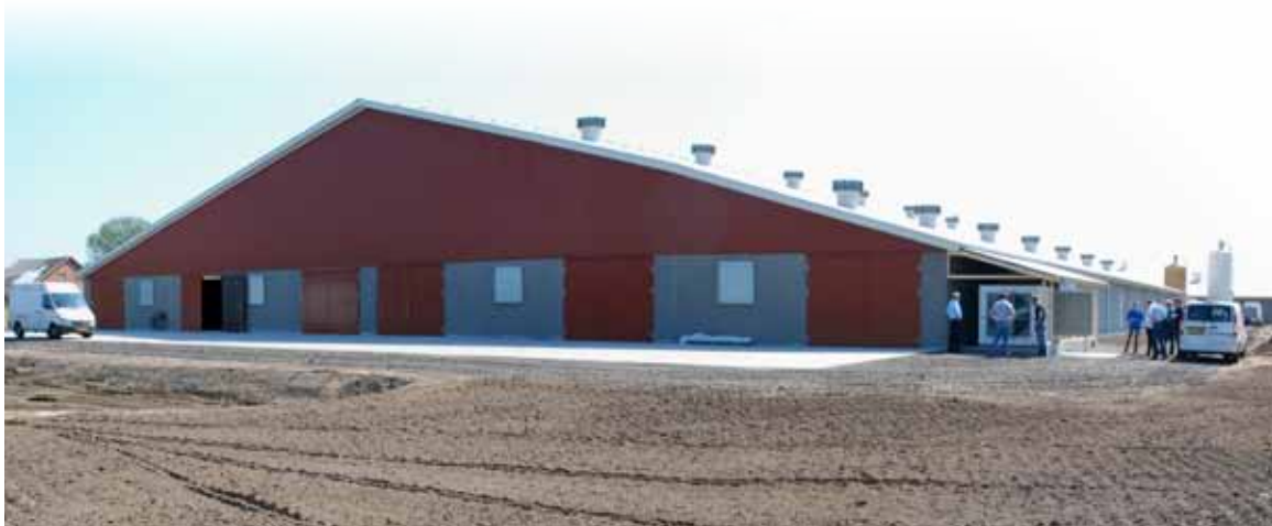
Den nye stald set fra gavlen med 'udhuset' til luftrensere i midten.
